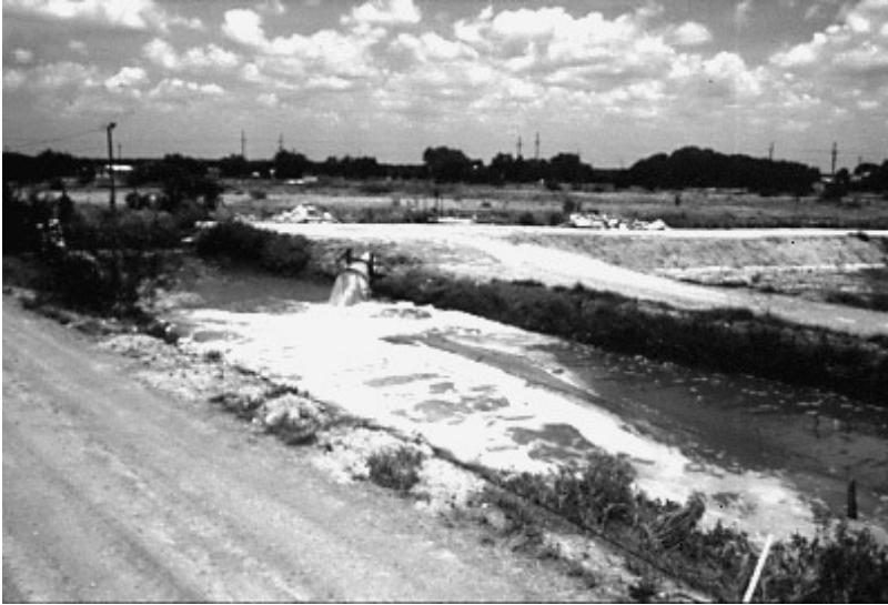
Fig. 15.5. Water reuse system at AAA.
